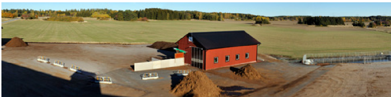
För hanteringen kring Trumkomposten krävs hårdgjorda ytor med åtskilda områden för in- och utgående material
